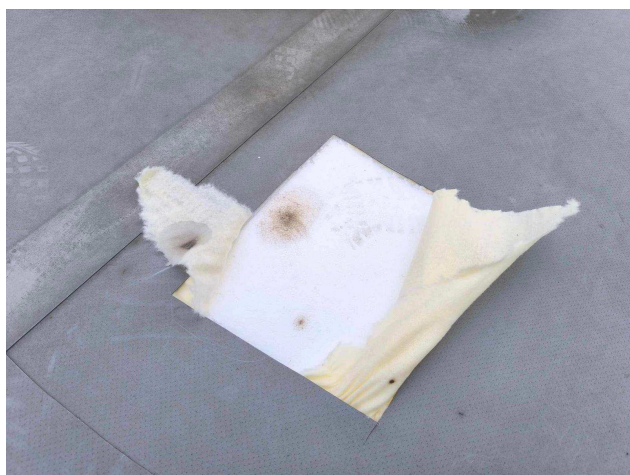
Foto 3 – Stav separační geotextilie a EPS
