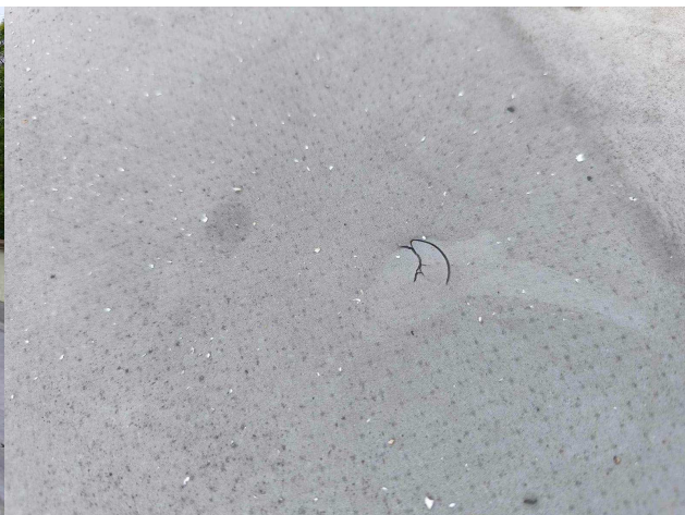
Foto 2 – Poškození na povrchu fólie
